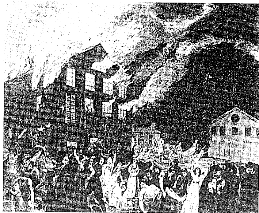
3. Incendio del teatro di Richmond (Usa). Litografia del 1812.
